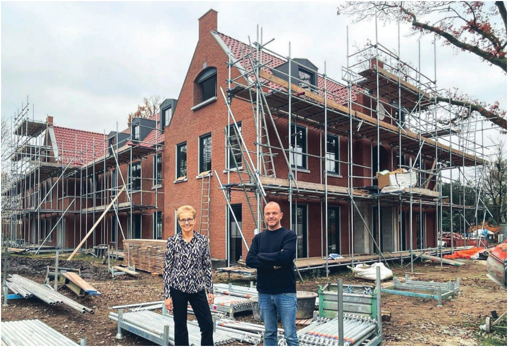
Ine en Alwin van Het Andere Wonen Eersel voor de in aanbouw zijnde Villa Nieuwzicht.
